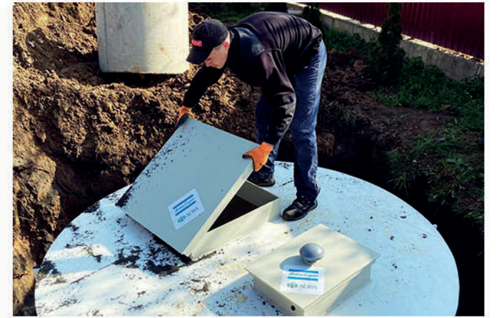
Встановлення каналізаційної системи
