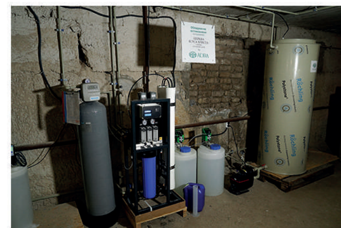
Встановлення системи очищення води
