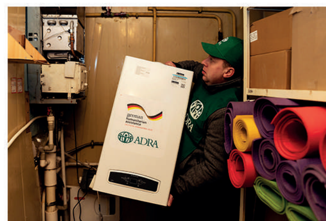
Встановлення системи опалення
