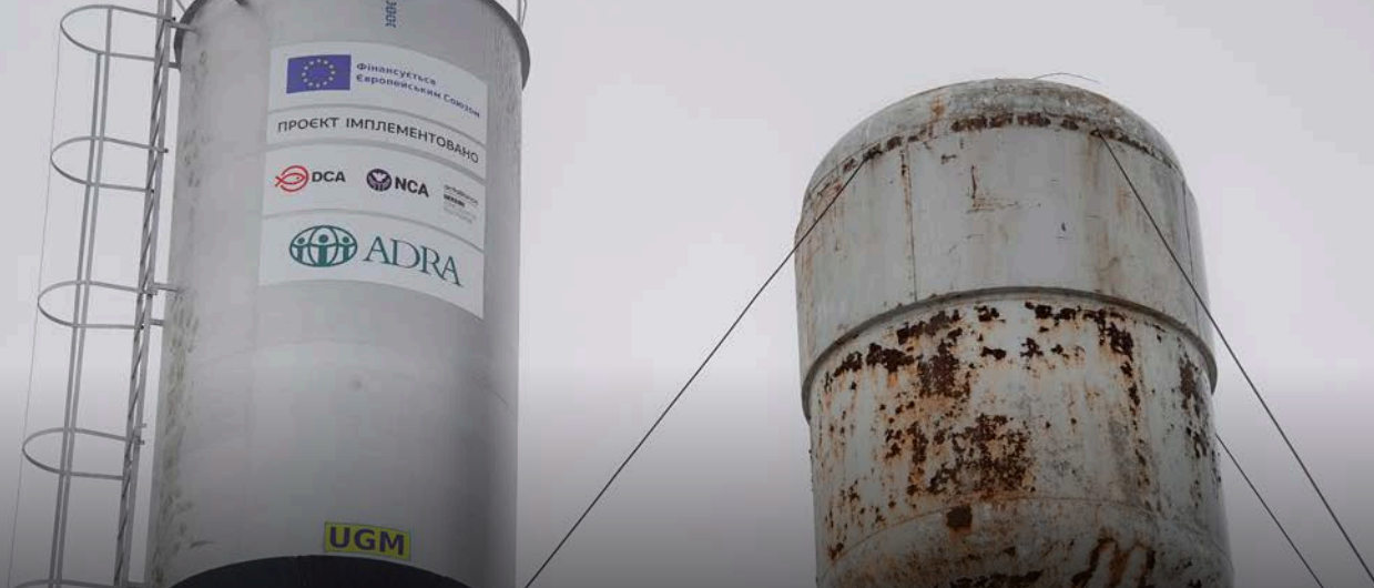
Встановлення водонапірної башти в селищі Первомайське Миколаївської області
